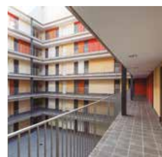
Nouveau bâtiment résidentiel. 84 appartements. Aquarea
