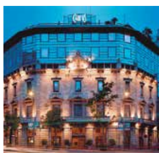
Rénovation d'un hôtel. Hôtel Claris 5*. ECOi
